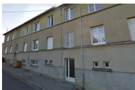
Rue du Couvent 6 appartements
