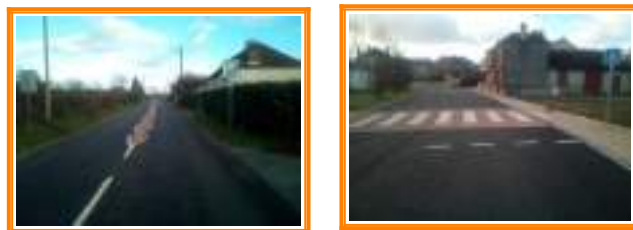
Photos de l'aménagement de sécurité avenue Alsace Lorraine
